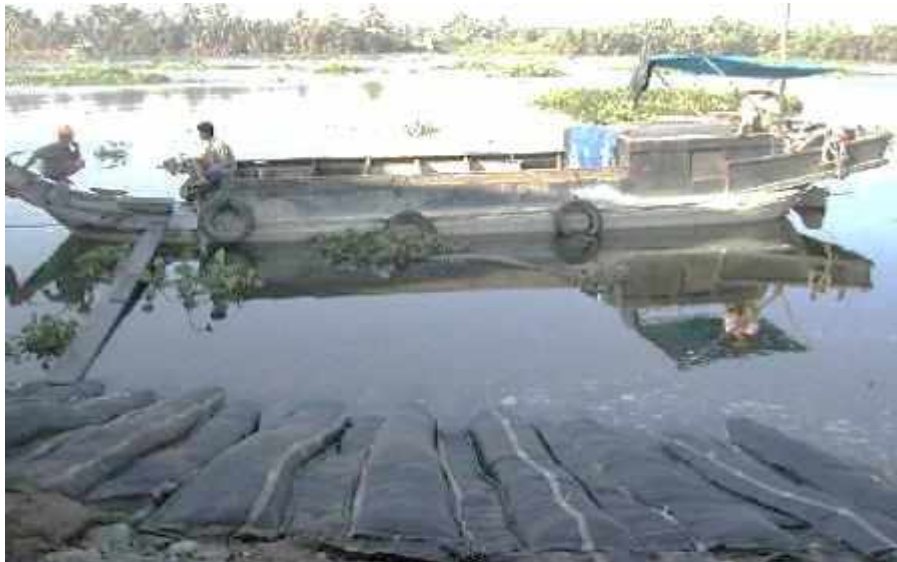
Hình 3. 8: Thảm túi cát và kè bằng thảm túi cát ở bờ sông Sài Gòn
